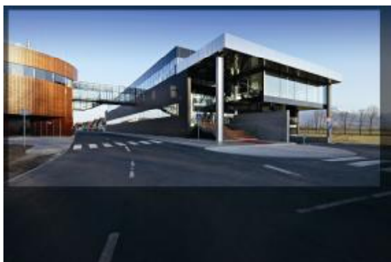
Výstavba administratívnej budovy GasOil Engineering a.s. Poprad Tatranská 742, Spišská Teplica, okr. Poprad autor: Peter C. Abonyi autor fotografií: Vladimír Yurkovic
